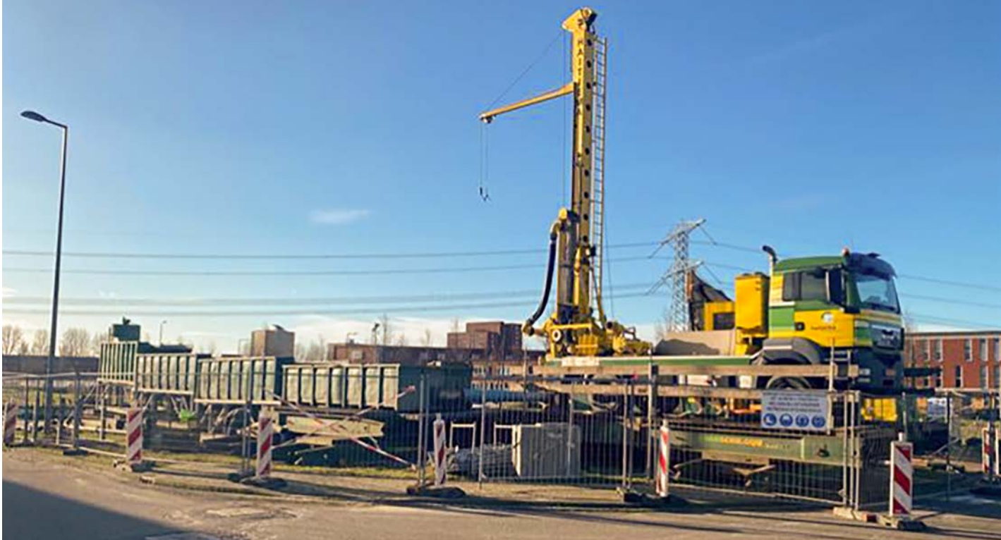
Boorinstallatie tijdens de proefboring in Rotterdam
